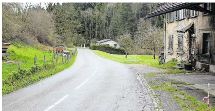
Ende März befinden die Zuzwiler über einen Kredit für die Sanierung der Oberdorfstrasse.
